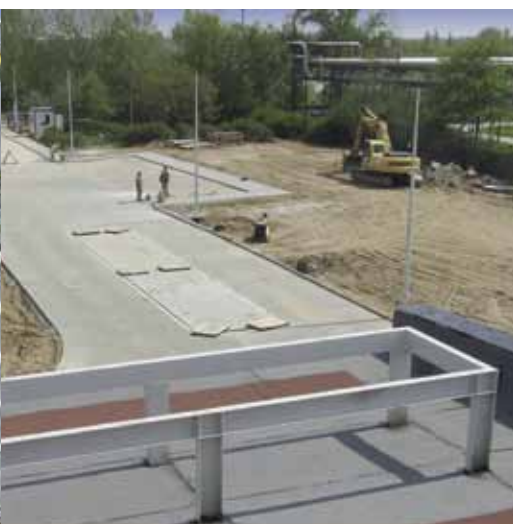
MAI 2010 Bau der Zufahrtsstraße mit LKW-Waage
