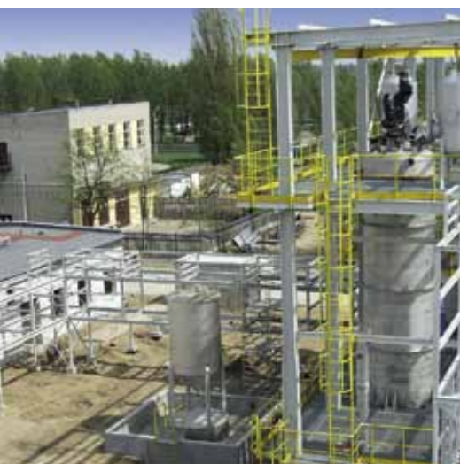
APRIL 2010 Ausrüstung des Reaktorbereichs
