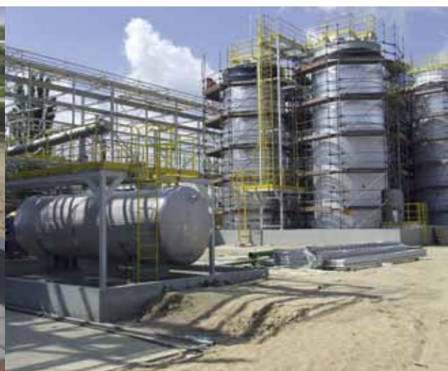
JULI 2010 Puffertank für Ethylenoxid vor Beginn der Isolierungsarbeiten
