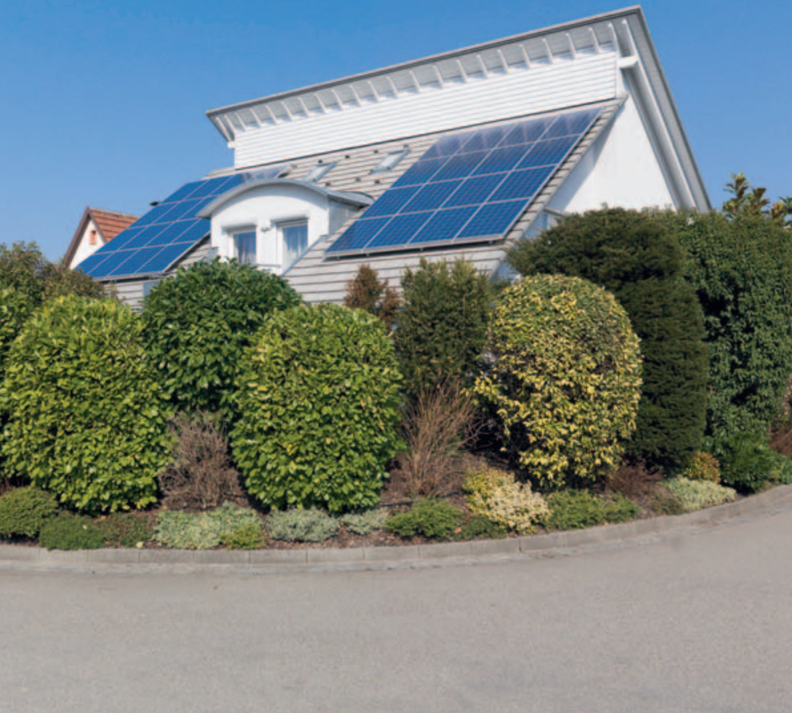
Dachanlage, Privatgebäude, Denzlingen, Deutschland, 5,92 kWp
