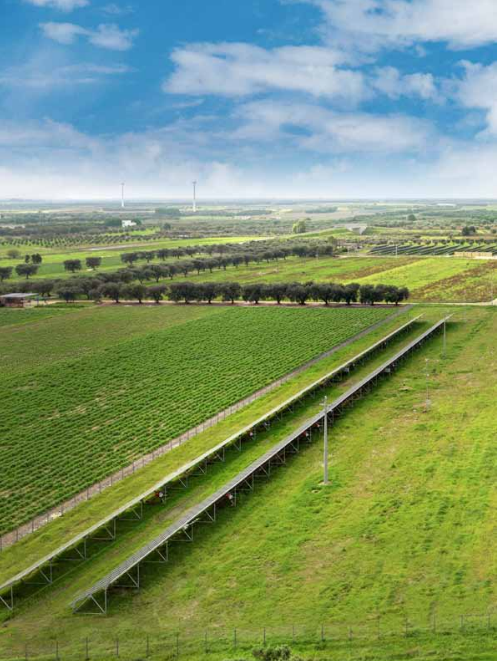
FREIFLÄCHENANLAGE, PROJEKT PUGLIA II COCCIOLO, APULIEN, ITALIEN, 999 KWP
