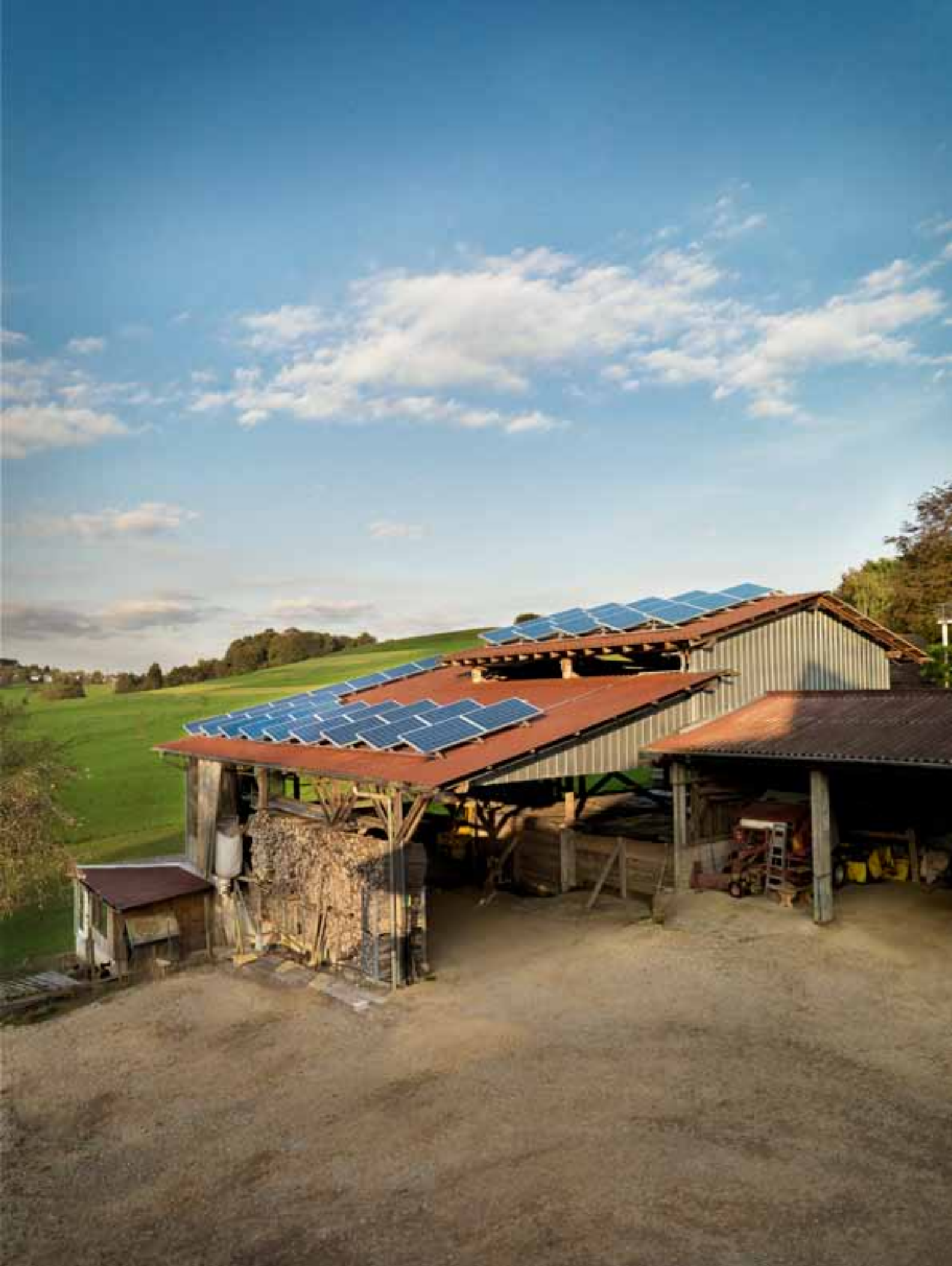
DACHFLÄCHENANLAGE, LANDWIRTSCHAFTLICHES GEBÄUDE, SÖLDEN, DEUTSCHLAND, 13,11 KWP
